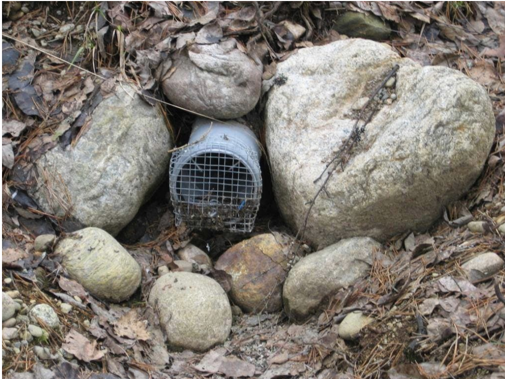
Kuva 8. Kaivoon voi virrata sulamis- ja tulvavesiä kuivatusputkea pitkin, jos takaisinvirtausta ei ole estetty. Kuvan suojaverkon silmäkoko ei ole riittävä estämään pieneläinten pääsyä kuivatusputkeen.
